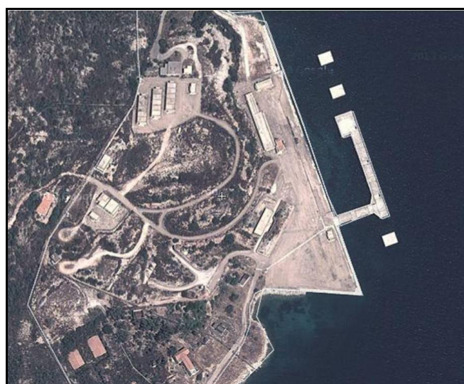
Figura 2 Dettaglio della Base Militare nell'isola di Santo Stefano con veduta sul molo sud oggetto dell'intervento
